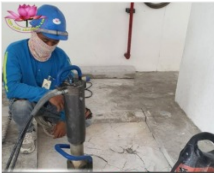
บริษัท เจอิน เอ็นจิเนียริง จำกัด รับเหมางานตัดคอนกรีต ขอนแก่น
